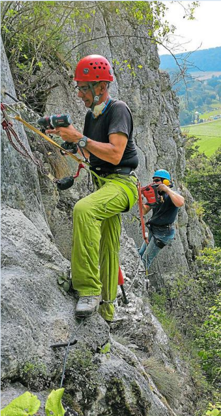
Mit zum Teil schweren Bohrmaschinen arbeiteten sich die ehrenamtlichen Helfer Loch für Loch voran, um neue Anker zu setzen. | Foto: Pruis-Obel
