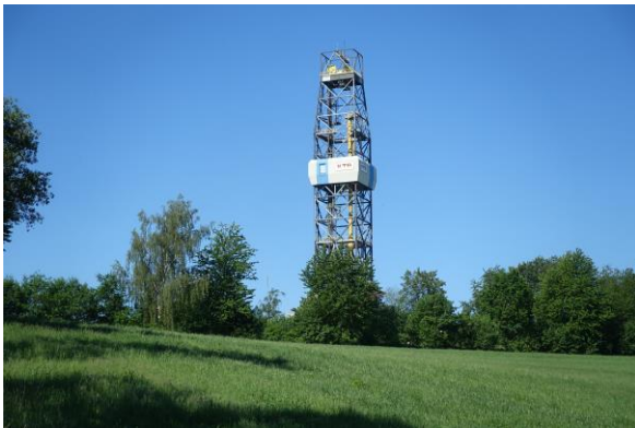
KTB Bohrturm 83m
